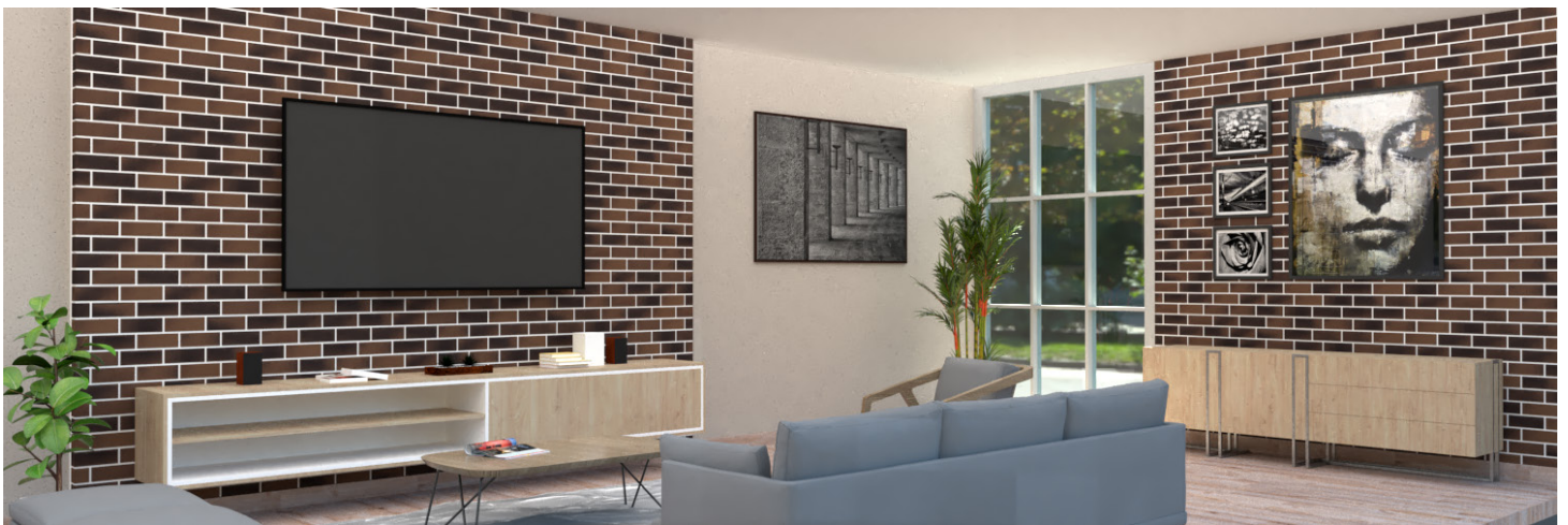
Aparejo sin cuatrapeo 0.5 vertical + 0.5 horizontal + 1 vertical con junta gris
